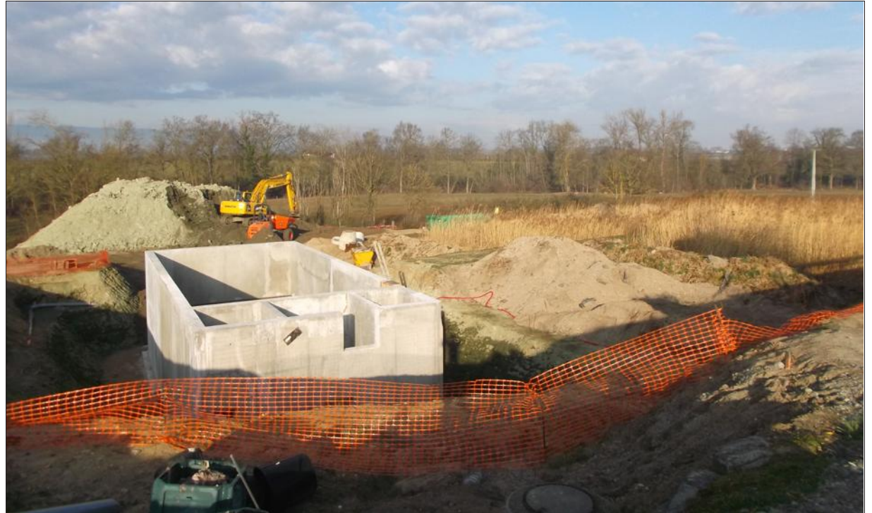
■ Les travaux ont commencé mi janvier. Photo Guillaume BOUCHUT
