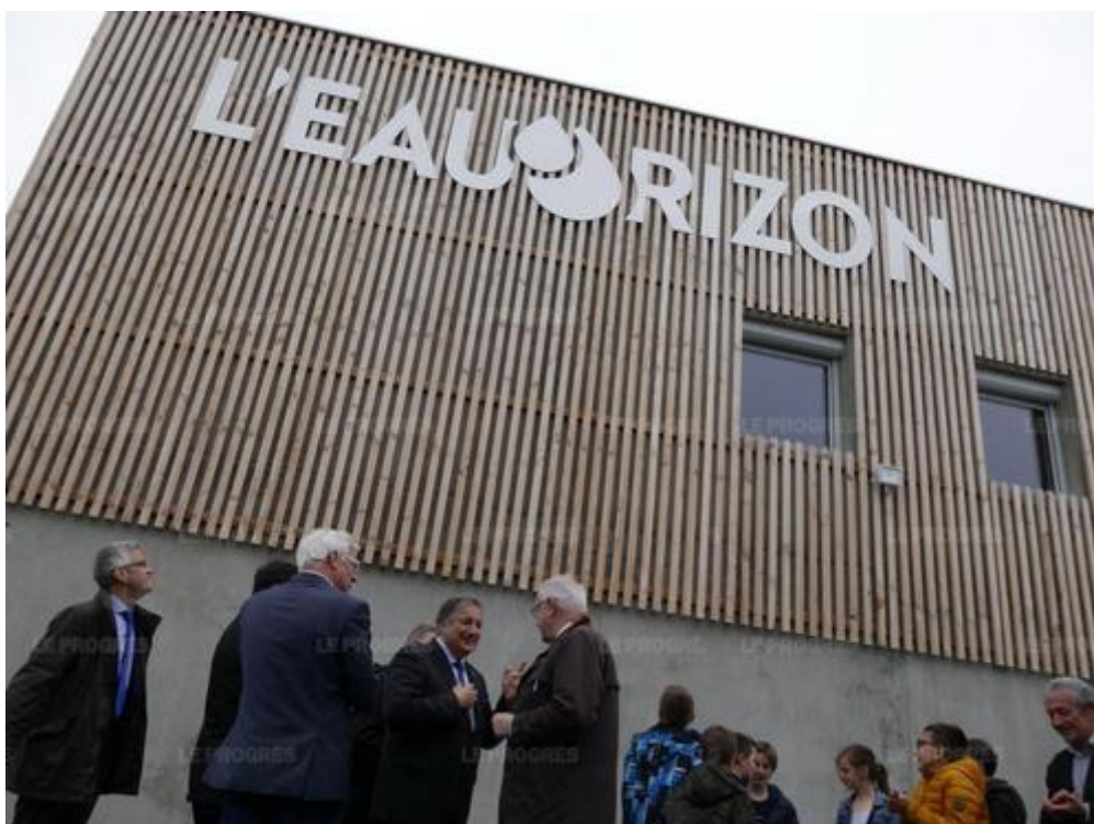
La station d'épuration a été inaugurée conjointement par les élus et des enfants, dans une démarche pédagogique. Photo Le Progrès /Boris DAUBE
